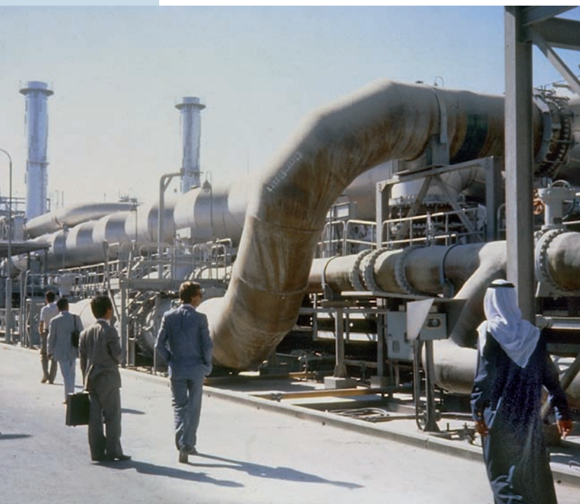
FIG|07| Negli impianti di dissalazione le lastre in cupronickel vengono impiegate come materiale per i serbatoi, i separatori a flash e i tubi di grandi diametri.
